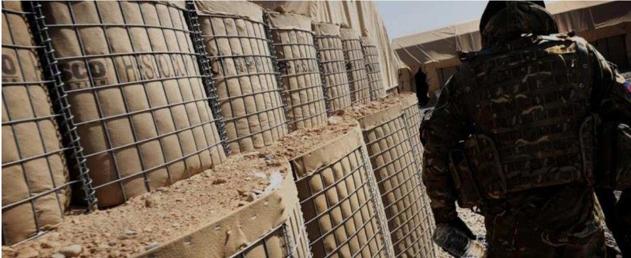
Figure 1-2 : Utilisations des gabions HESCO comme moyen de protection [2]
